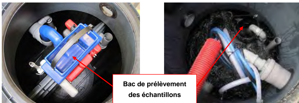
Bac de prélèvement KLARO Quick
